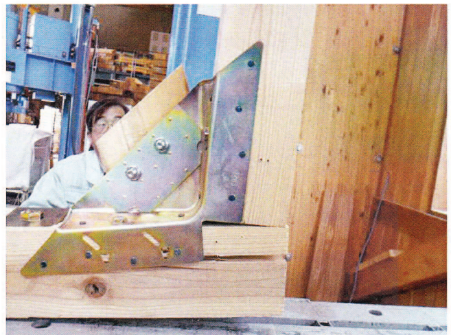
写真4. 2. 4 釘による土台の割れ
