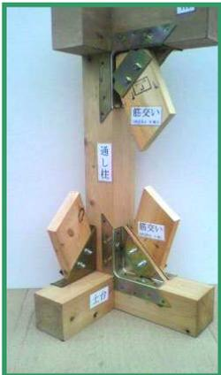
唯一、木造を筋交いの引張り耐力活用・通し柱の3次元補強等の複合効果で2倍以上の耐震性能にする工法。「耐震+制震+粘り」で、衝撃力や強い揺れ・余震に強い木構造にします。施工は簡便、居ながら補強も可。現実の補強効果も動的診断で確認可。費用対効果に大きな差がでる確実な補強が可能な画期的な補強工法です。
